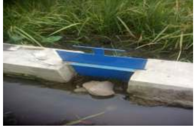
Pembangunan pintu air
